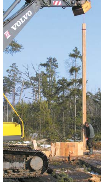
Einbau der Spundwände
